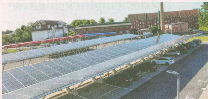
Parkplatz mit Solarcarports auf dem einstigen Eierlager-Gelände FOTOS: NEUMANN
